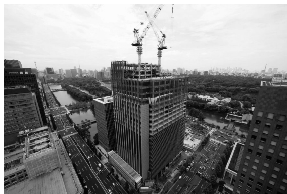
建設中の本店ビル
