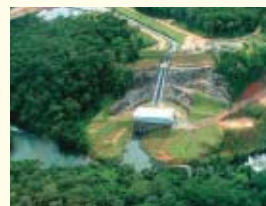
ブラジルのCDMプロジェクト (アラセル小水力発電所)
