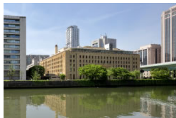
改修工事を終えた大阪本店
