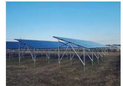
農地に支柱を立て、配置したソーラーパネル (株式会社トーヨーエネルギーファーム)
