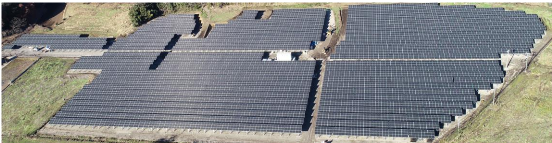
図表 2-8 オフサイトコーポレート PPA (茨城県)
