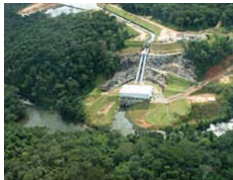
アラプセル小水力発電所
