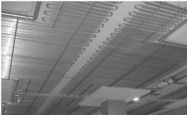
天井へアピコイル冷却方式によって冷蔵倉庫内の温度・湿度を一定に保持
