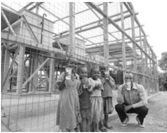
UNDPと共同でケニアに設置した運河の水を浄化する「緩速ろ過装置」。
