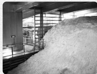
八海山雪室の中は、雪の冷気で夏でも約4℃以下に保たれている。
