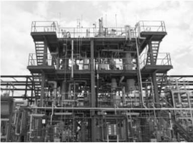
千代田化工建設が建設した小型デモプラント。毎時50m<sup>3</sup>の水素化反応と脱水素反応を繰り返す。
