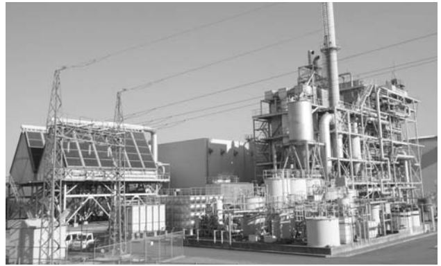
木質バイオマス発電所 日田発電所 発電出力:1万2,000kW
