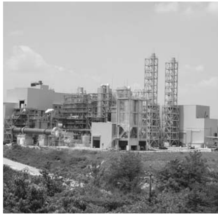
最新の焼却施設を備えた三重リサイクルセンター 「エネルギープラザ」
