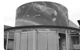
宇宙太陽発電 実験棟
