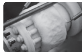
ノンフロン冷凍機としての活用も期待されている
