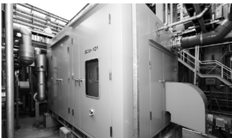
灘魚崎工場のヒートポンプシステム
