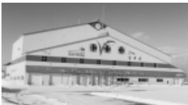
1996年に建設された北海道沼田町の米穀低温貯留乾燥調整施設。2～3月に蓄えた雪の利用で、内部は平均温度5℃、湿度70%に保たれる
