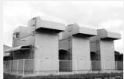
志度工場の自家発電機
