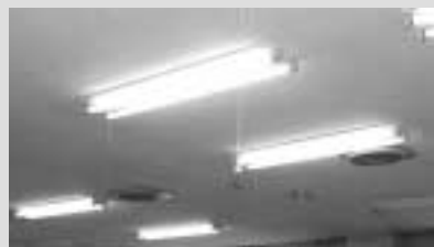
施工状況 事務所棟(外観上の違いはない)
