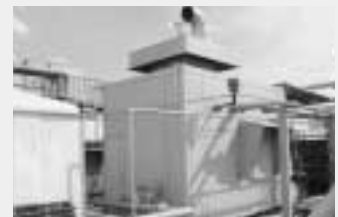
コンプレッサ(建屋内)
