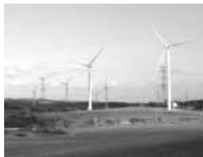
青森県六ヶ所村に立ち並ぶ 20基の大型風力発電機
