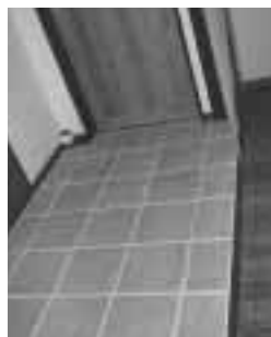
客間の土間の床材には、珪藻土で作られ調湿性を持つタイルを使用している。
