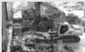
ニブラでさらに解体。大きな部品を材料別に取り出す
