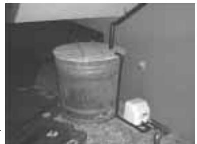
古酒樽で雨水を溜め、中庭に散水している。
