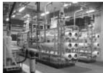
逆浸透モジュールユニット(機械室)。半透膜には60気圧ぐらいの圧力がかかるので、これに耐える強度が要求される。半透膜にサポート材やスペース材を組み合わせ、束ねてコンパクトに成形して耐圧筒に納めたものを逆浸透モジュールと呼ぶ。これを多数集めてユニット化し、このユニットを複数組み合わせてプラントとする。
