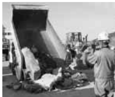
荷下ろしの行程を撮影するドライバー
