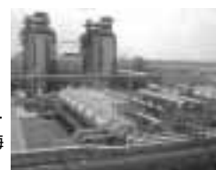
中東地域(オマーン)の蒸発方式海水淡水化プラント
