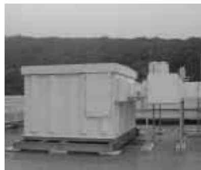
都立三宅高等学校に設置された脱硫装置
