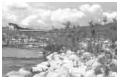
ストーンネット工法での施工後4年を経て、植生を取り戻した新田川(山形)
