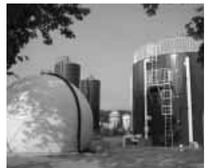
くずまき高原牧場のバイオガスシステム
