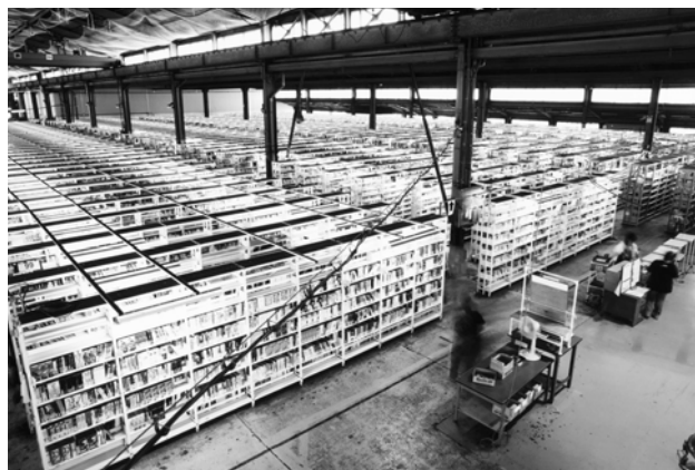
トヨタ生産方式を駆使した総面積2,200坪の商品倉庫
