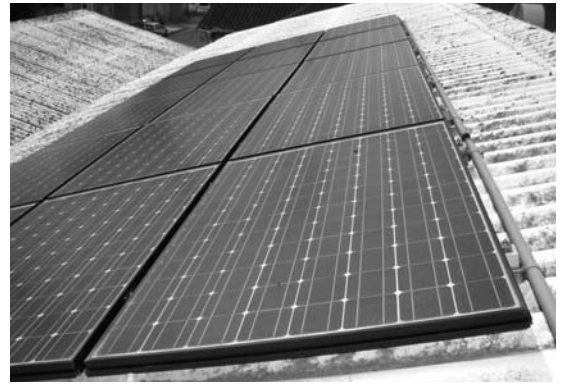
市民共同発電所プロジェクトにより設置された太陽光発電装置
