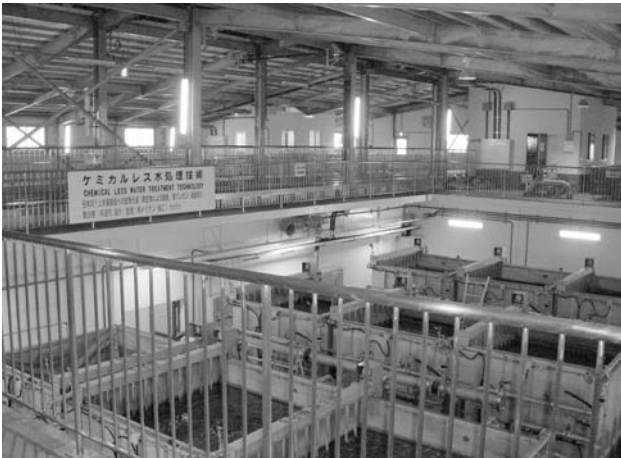
母坪浄水場に設置されたケミカルレス水処理装置
