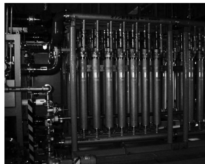
高度な処理が可能な膜処理技術（膜モジュール、芝浦水再生センター）
