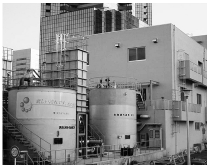
再生水造水施設（芝浦水再生センター）
