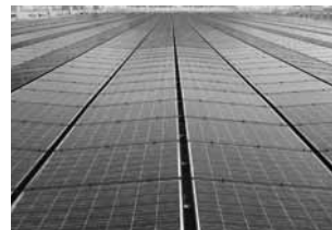
シャープ亀山工場に設置している大規模太陽光発電システム
