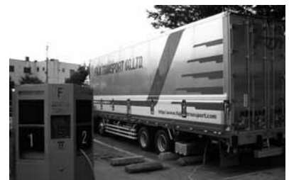
給電スタンドは、1基で2台のトラックに給電でき、各々単相交流100Vと200Vのコンセントを収容している。
