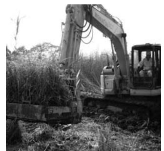
写真1: 生態系をまるごと移植する「表土ブロック移植工法」
