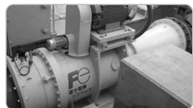
配水池にある減圧弁の代わりに富士マイクロチューブラ水車（M型）を設置した例。
