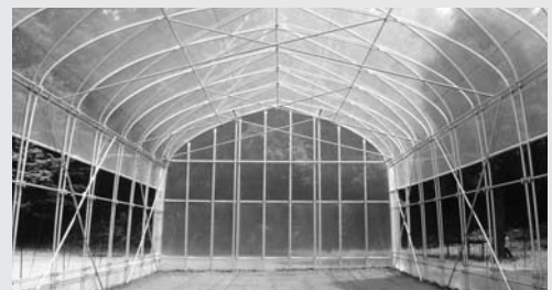
複数の三角構造の組み合わせによって、1.5倍の強度を実現
