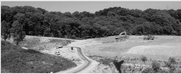
周囲を囲む塀もない緑豊かな処分場は、開放的で誰でも見学することができる
