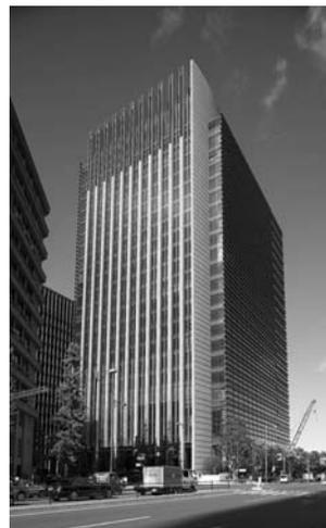
三井住友銀行本店ビルディング(東京都千代田区丸の内)。最適な昼光が入るよう自動的に動く太陽追尾型電動ブラインドや、自然光をビルのコア部まで引き込む光ダクトを導入。また、雨水をトイレ洗浄水などに有効利用するための貯水槽を設置するほか、太陽光発電や水蓄熱システムが設置されており、建築物総合環境性能評価システム「CASBEE」では最高評価のSランク。
