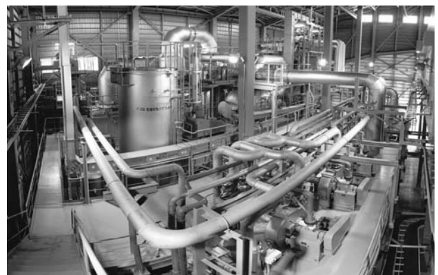
下水汚泥の固形燃料化プラント
