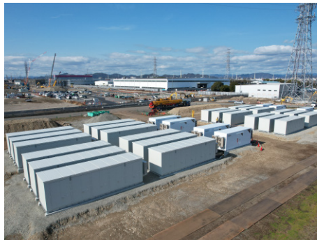
兵庫県姫路市にある出光興産兵庫製油所跡地の遊休地に系統用蓄電池の設置を進めている
